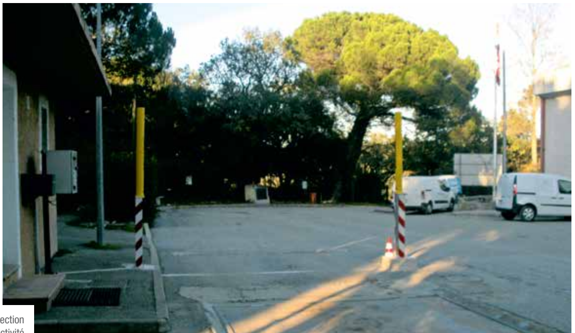
Pont hors sol de 18 m pour pesées des semi-remorques FMA
