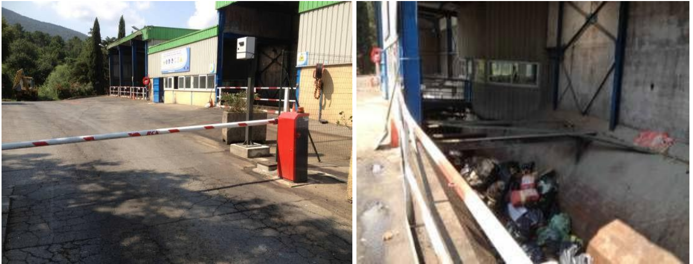
Le quai de transit des OMR et ses fosses de déchargement
