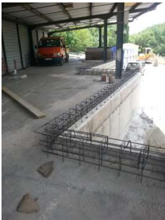
Réalisation des butées de quai en béton
