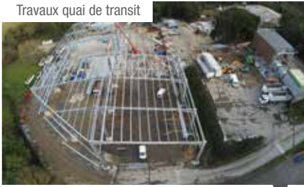
Travaux quai de transit
