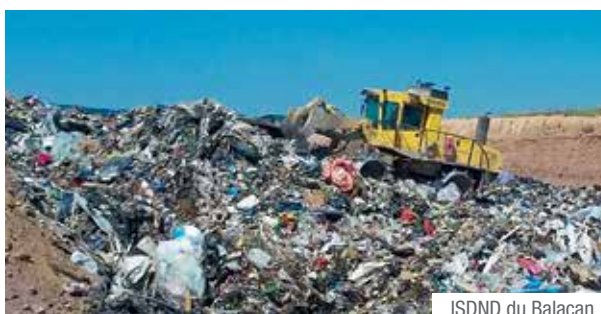
ISDND du Balançon
